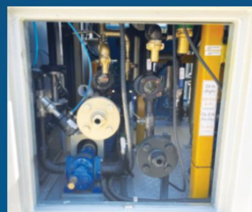
Olein- und -auslassventile (mit Flanschen oder Schlauchanschlüssen)
